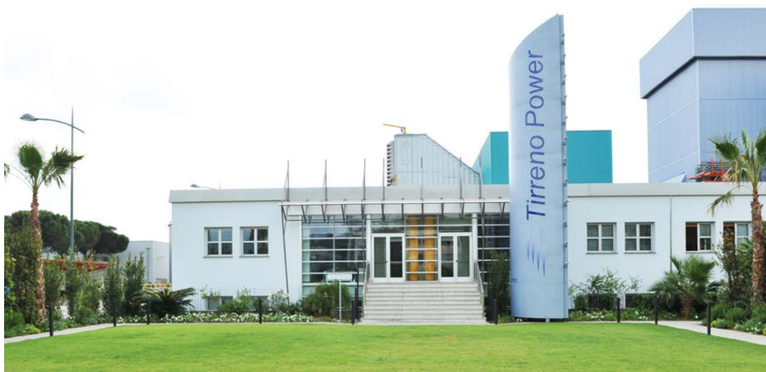
Centrale di Vado Ligure
