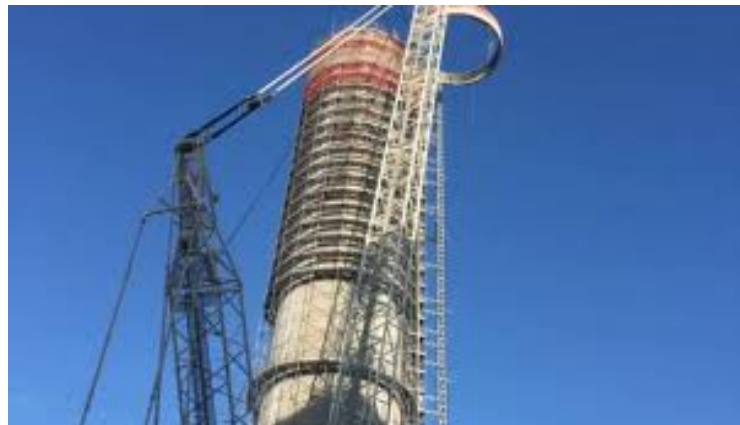
C.le Vado Ligure – attività di demolizione della ciminiera
