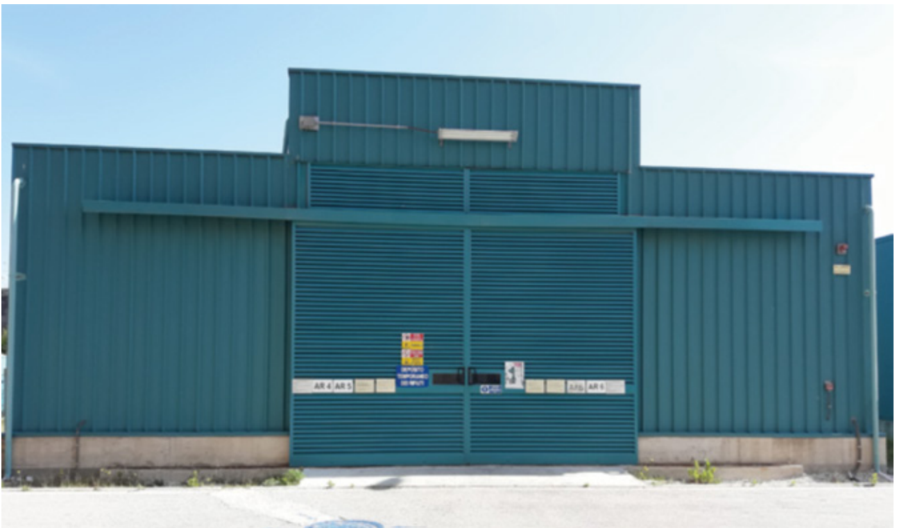
Figura 15: Deposito temporaneo rifiuti non pericolosi
