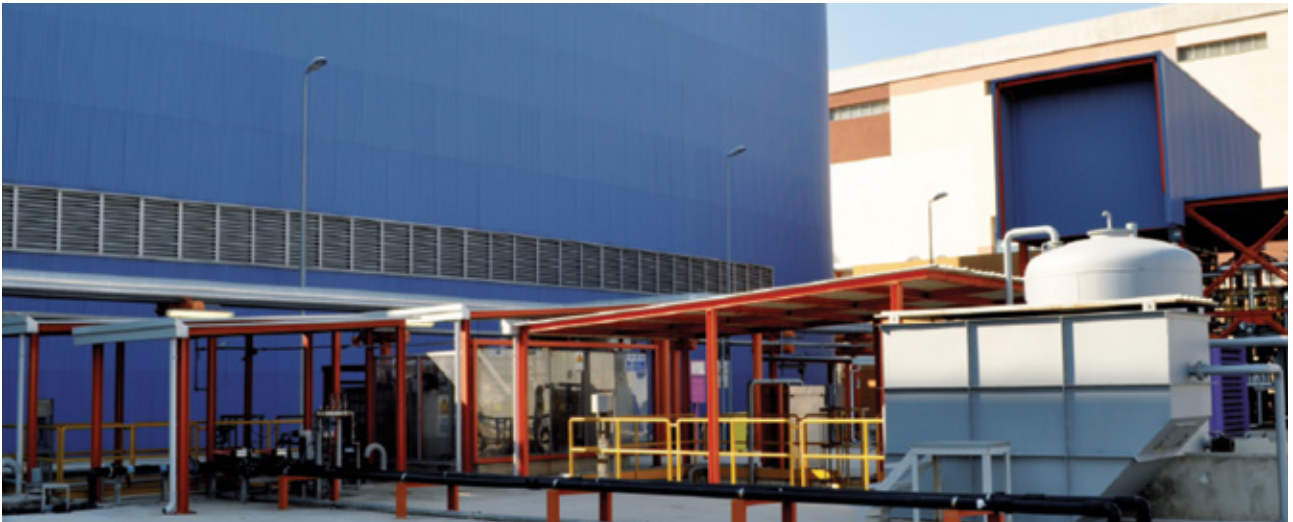
Figura 12: Impianto di Trattamento delle Acque Reflue
